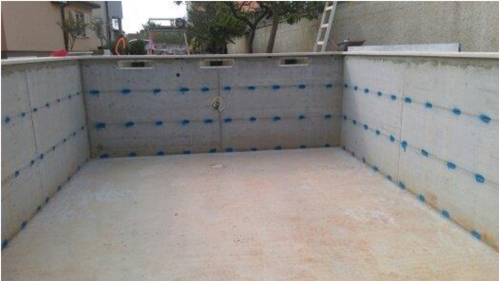
Slika 3.4. Provjera bazenske konstrukcije
