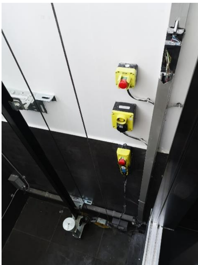
Slika 17: Prikaz sigurnosnih tipki u jami voznog okna
