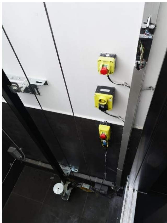
Slika 17: Prikaz sigurnosnih tipki u jami voznog okna
