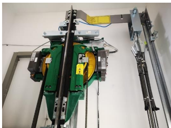
Slika 13: Pogonski stroj - vitlo
