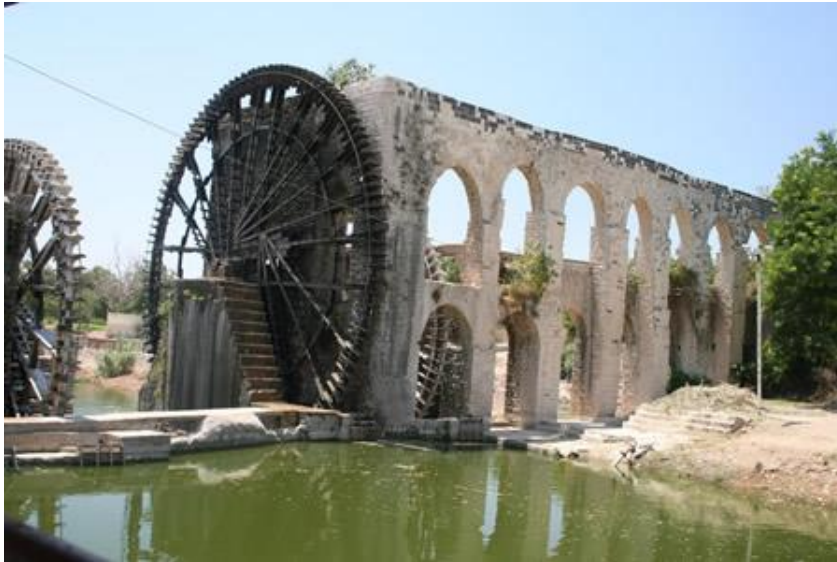
Slika 2.3. Kotač u sklopu Rimskog akvadukta
