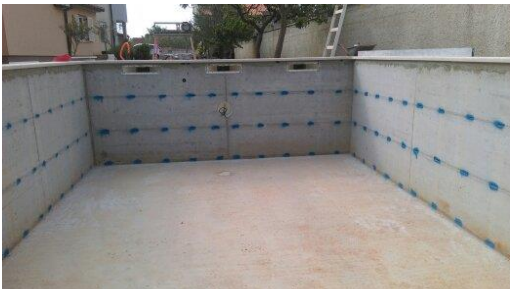
Slika 3.4. Provjera bazenske konstrukcije
